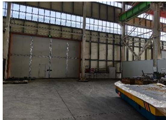
探伤室拟建位置
